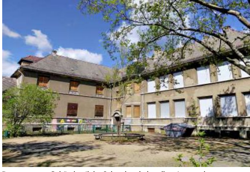
Der ungenutzte Gebäudeteil der Sekundarschule soll saniert werden. FOTO: BRIEST
