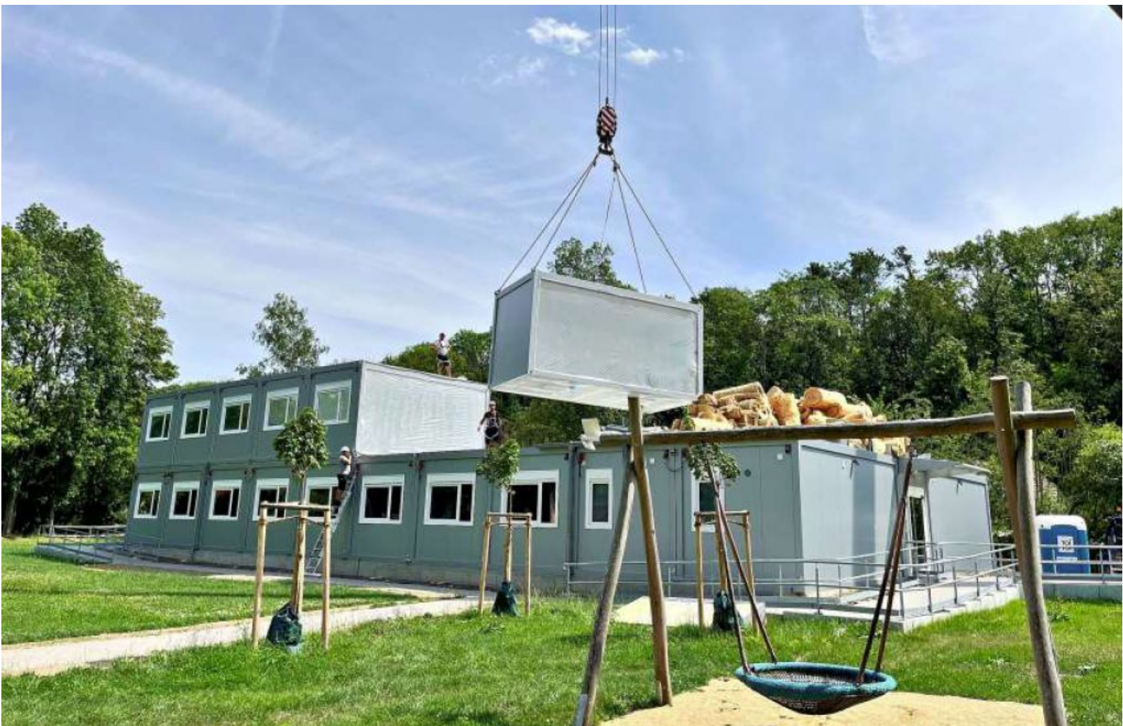
Die Container für neue Klassenräume der Förderschule Merseburg wurden am Standort Mücheln mit einem Kran aufgestellt.
